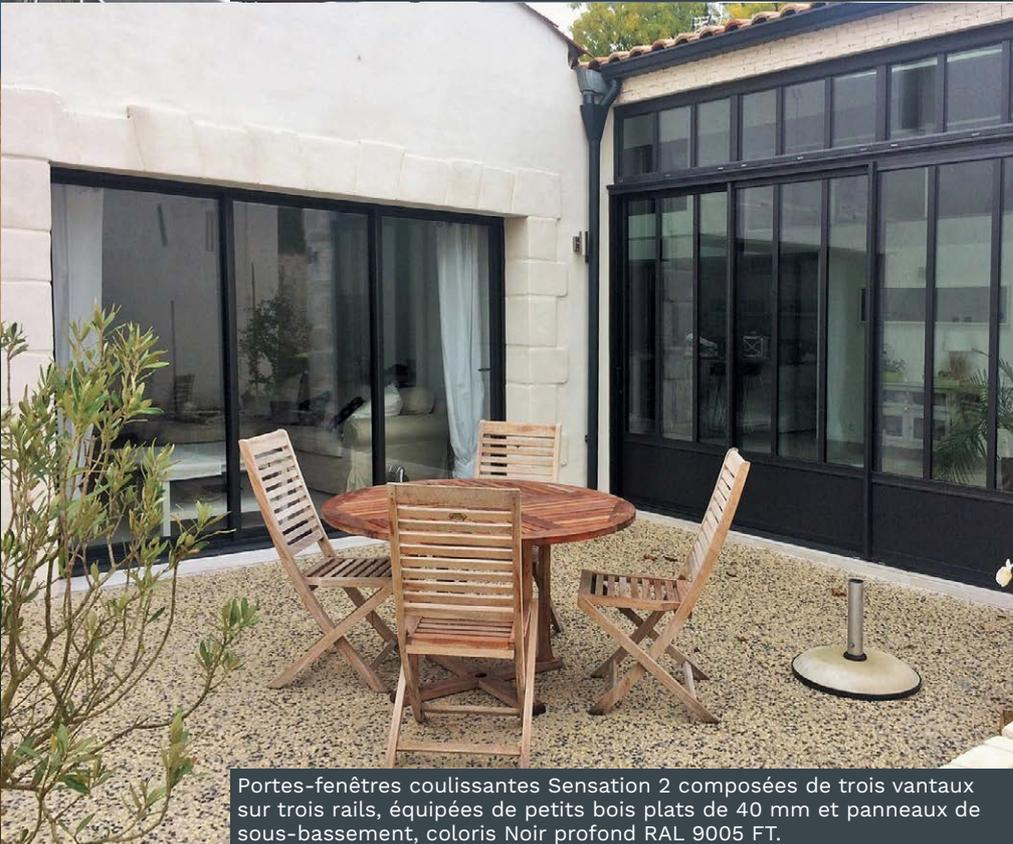
Portes-fenêtres coulissantes Sensation 2 composées de trois vantaux sur trois rails, équipées de petits bois plats de 40 mm et panneaux de sous-bassement, coloris Noir profond RAL 9005 FT.
