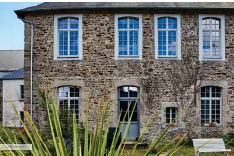
Ouvrant extérieur type "solin mastic à l'huile de lin"
